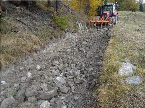
Mit dem Steingrubber werden die Wege in gewünschter und benötigter Tiefe aufgerissen. Die Fahrspuren und Schlaglöcher werden dabei egalisiert. Beim Aufreißen der Decke gelangen Steine unterschiedlicher Größe an die Oberfläche.
