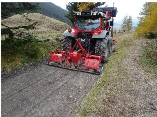
Die neue Deckschicht wird nun mit der Dreifach-Rüttelplatte verdichtet. Durch die spezielle Aufhängung der Platten erhält die Fahrbahndecke bei diesem Vorgang die nötige Festigkeit.
