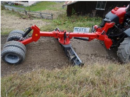
Bei der Feinprofilierung wird mittels eines hydraulisch gesteuerten Planierschilds die Deckschicht verteilt. Danach erhält der Weg das gewünschte Profil und die gewünschte Neigung.
