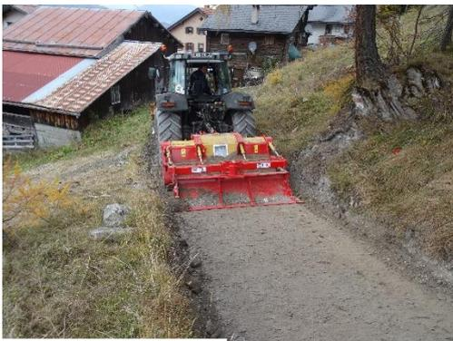
Um den Unterbau besser mit der Fahrschicht zu verbinden, wird mit dem Steinbrecher nun die freigelegte Schicht mühelos zerkleinert und nochmals gemischt. Mit der Brechleiste kann die Korngröße individuell eingestellt werden. Die Kornstruktur trägt entscheidend zur Tragfähigkeit der Deckschicht bei. Das Material weist eine kantigere Oberfläche als gewaschenes Kies auf, was eine optimale Bindung verspricht.
